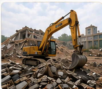
Đập phá công trình
