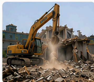
Phá dỡ công trình
