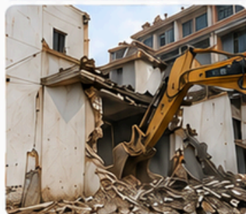
Đập phá công trình
