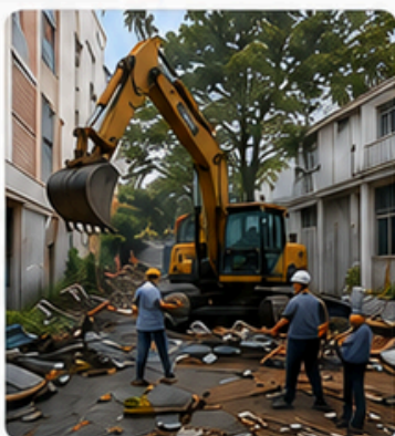
Thi công phá dỡ
