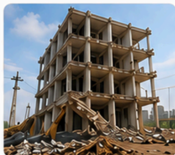
Phá dỡ công trình
