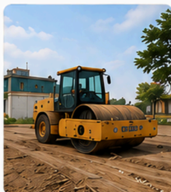
Thi công san lấp mặt bằng
