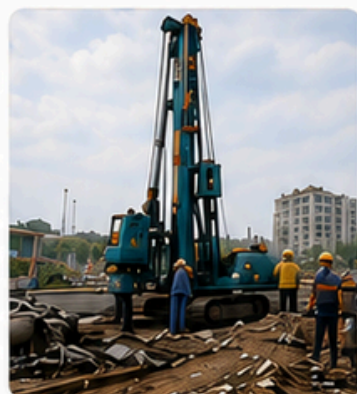
Thi công xử lý nền móng
