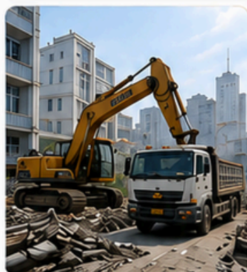
Thi công phá dỡ
